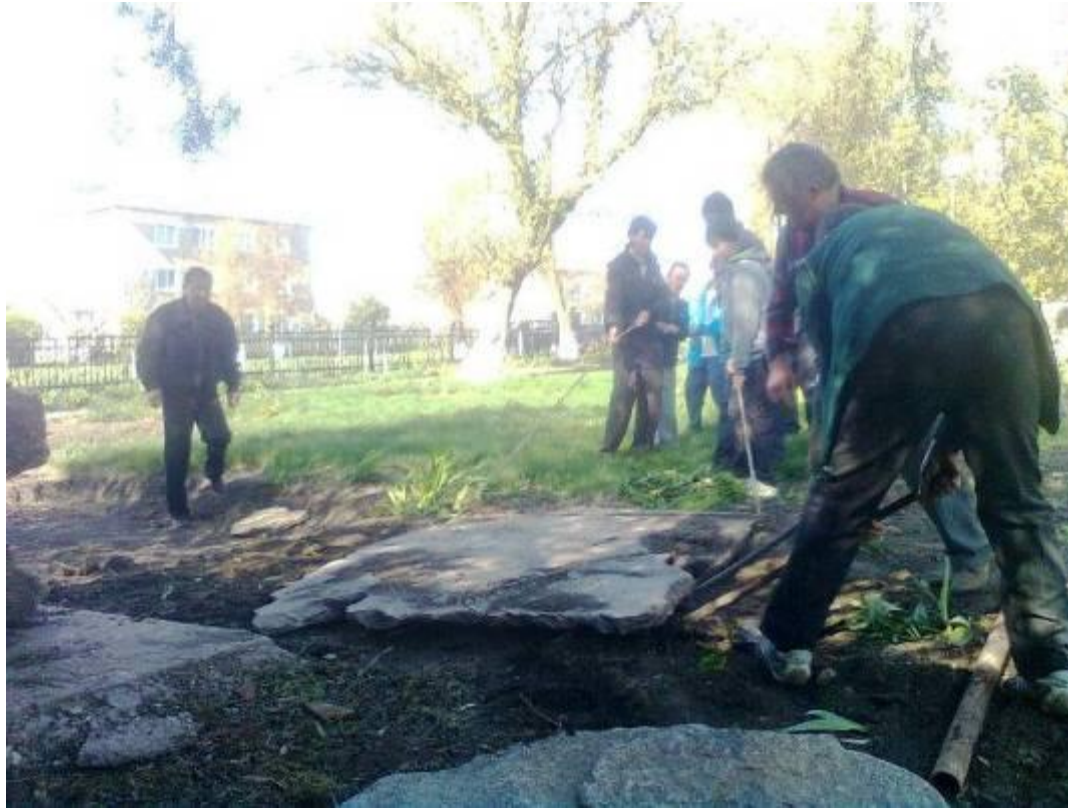
Рис. 3.1 – Будівництво водоспаду з водоймою. Укладання каналної плити під фундамент водоспаду.
